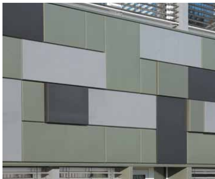
Kantoorgebouw, Tineux (Frankrijk) - Architect : Borderieux/Di Legge Reims Installateur : GAYET
