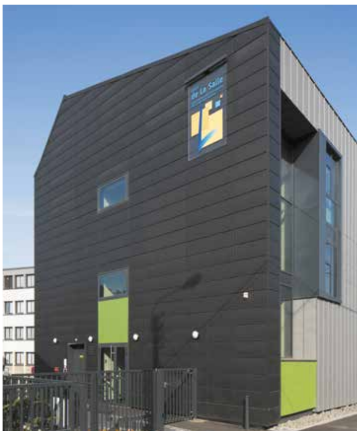
School, Rennes (Frankrijk) - Architect : Louvel Associés - Installateur : CCL LUCIEN
