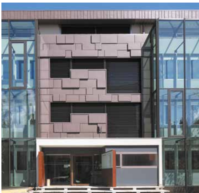
Notariskantoor, Bordeaux (Frankrijk) - Architect : Teisseire & Touton - Installateur : Moriceau
