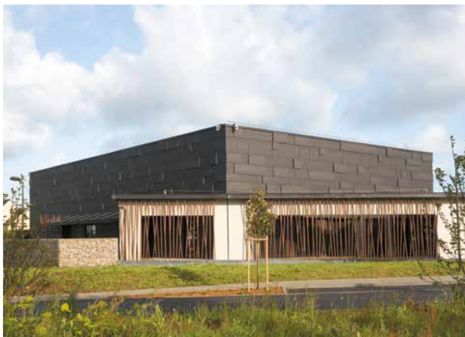
Polyvalente zaal, Saint Avé (Frankrijk) - Architect : Archipole Rennes - Installateur : Quemard
