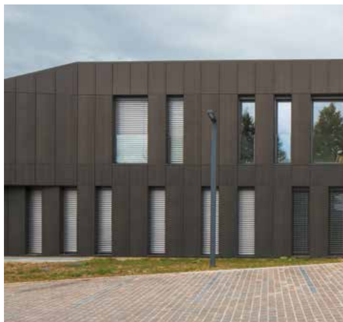
Gezondheidscentrum, Crécy-sur-Serre (Frankrijk) - Architect : Gissinger + Tellier Architectes. Installateur : Caron SA
